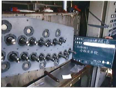
脱水機オーバーホール
