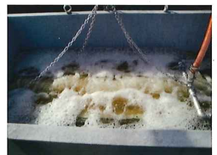
膜式排水処理設備 膜モジュール薬品浸漬作業
