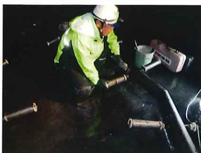
曝気槽 散気管交換
