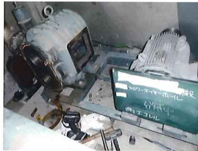
曝気ブロウ 分解整備
